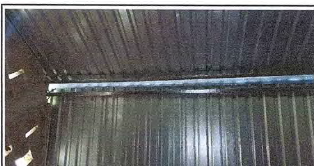
Foto 6: vista del interior de cocina ya con el techado
