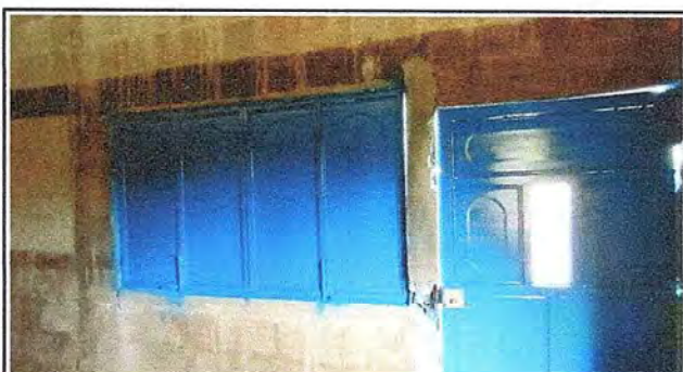
Foto 4: Vista interior de cocina
