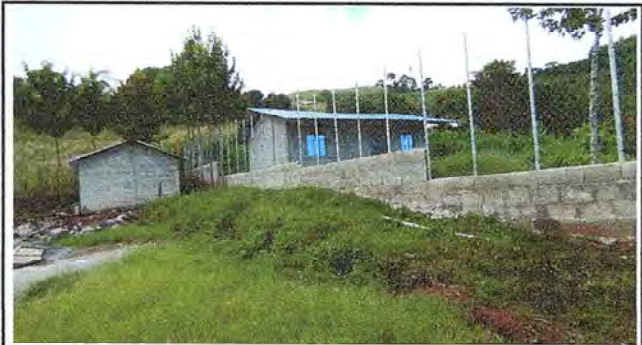
Foto 2: Otra vista de muro perimetral
