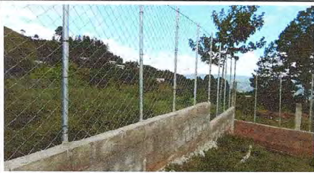
Foto 1: Vista de muro perimetral terminado.
