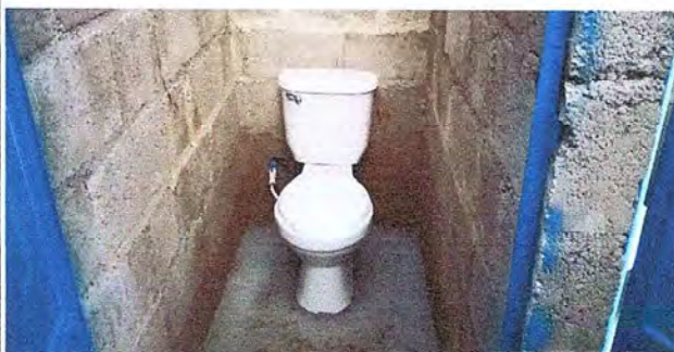
Foto 4: Vista de uno de los sanitarios
