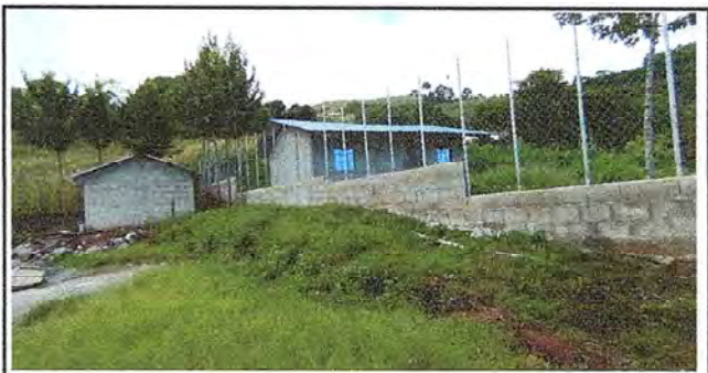
Foto 6: Otra vista de muro perimetral
