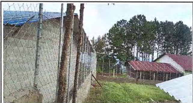
Foto 4: Así quedó instalado el muro perimetral
