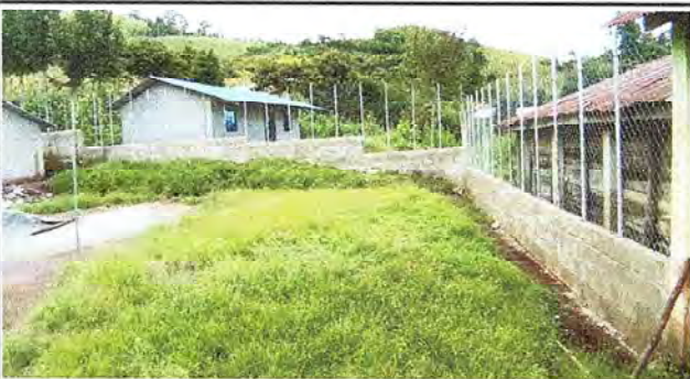
Foto 3: Otra vista de muro perimetral terminado
