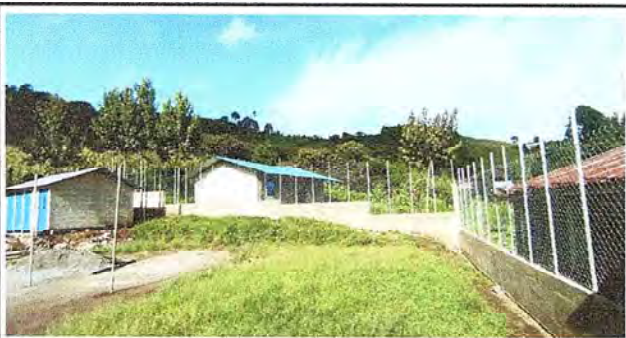
Foto 5: Vista completa de muro perimetral
