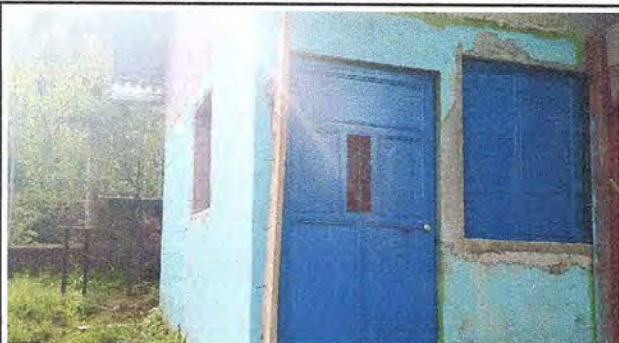
Foto 1: Asi quedó la instalación de puerta y ventana de cocina
