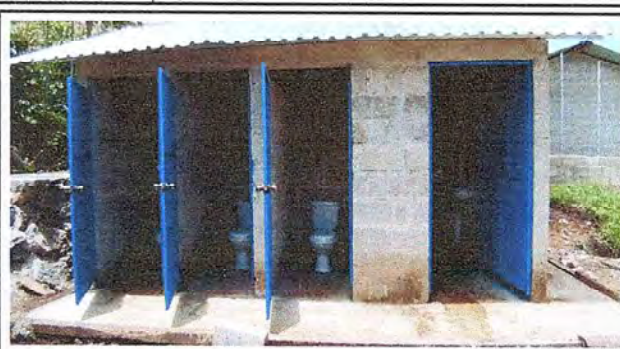
Foto 2: Vista frontal de baño, puertas abiertas
